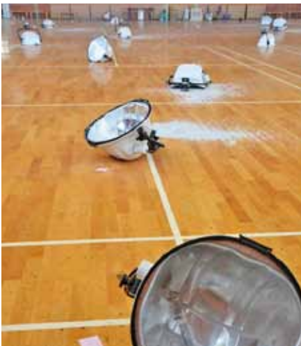
体育館に落下した照明(富岡町)
