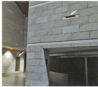
写真2 空調を介して展示室に適正な空気が送り込まれる（手前の矢印は吹き出し口、奥は吸い込み口）
