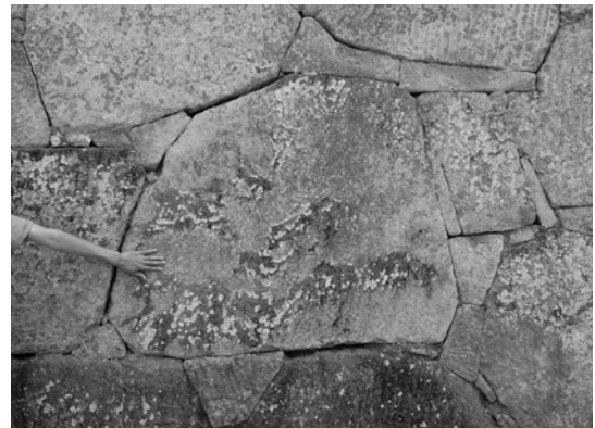
7-4 7-3の角閃石を含む石垣（走長屋の北側 江戸時代 前期の築造、後年改修）
