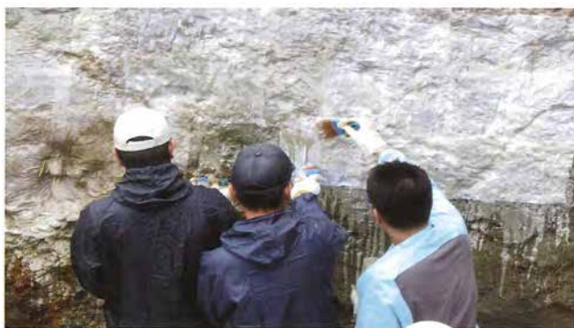
土層剥ぎ取りのための接着剤塗布（いわき市）
