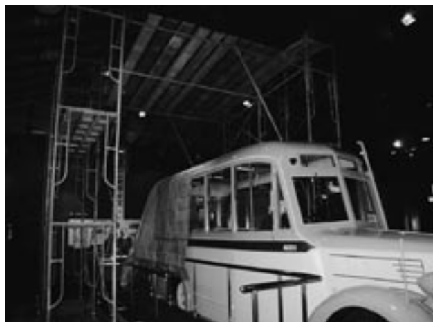
展示室の修繕風景
