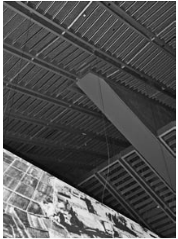
「古代」での天井の躯体と大型パネルを 連結しているワイヤのゆるみ
