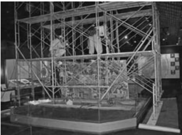
櫓を組んでパネルの撤去
