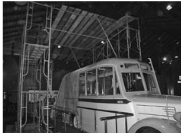
櫓を組んで行った木炭バス直上の天井の修復
