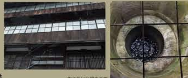
吹き抜けに残る井戸
